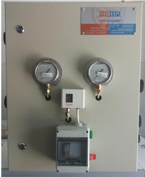
1. Предназначен для распределения теплового потенциала горячего газа между нагрузкой (фанкойлы внутри помещения), выносным конденсатором и ресивером.
