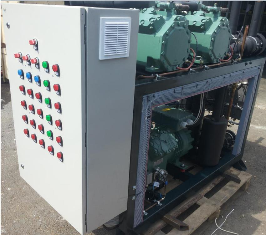
1. Экономия места. Модуль HR UNIT встроен в раму холодильной машины и не занимает пространство в компрессорной.
